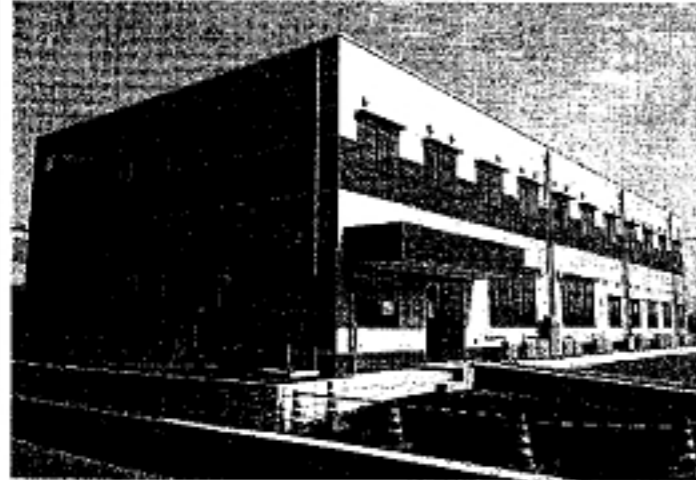
有料老人ホーム「オレンジ」の新棟
